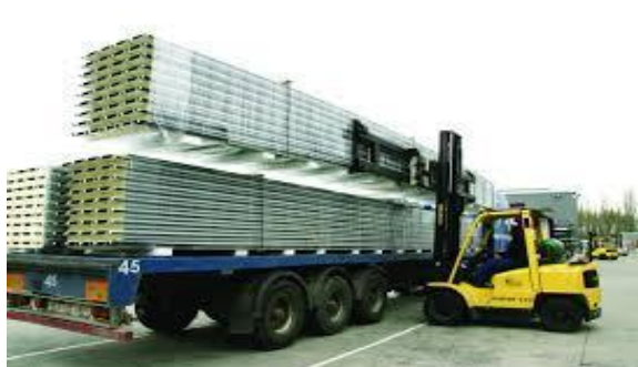
(ukázka vykládání panelů vysokozdvížným vozíkem)
