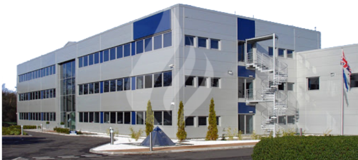
(ukážka budovy zo sendvičových panelov)
