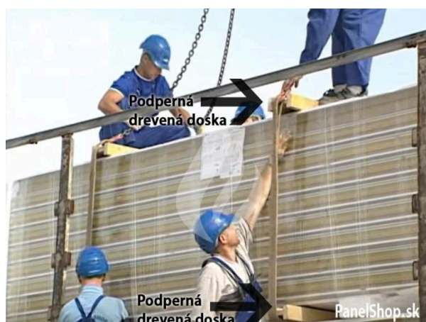
(ukázka podperné dřevěné desky ze spodu a z vrchu balíku)
