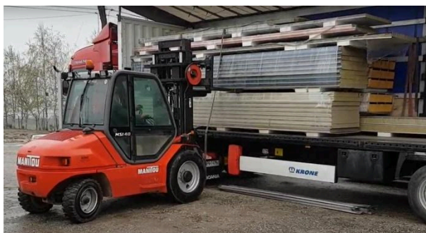
(ukázka vykládání panelů vysokozdvížným vozíkem)
